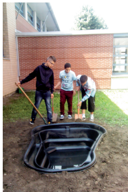
Un petit bassin qui accueillera bientôt des poissons et des plantes aquatiques.
